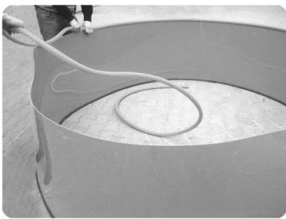
5. На верхний край пластикового каркаса легким постукиванием молотка одеть разрезанную вдоль, трубку меньшего диаметра, отрезав при необходимости лишнее.
