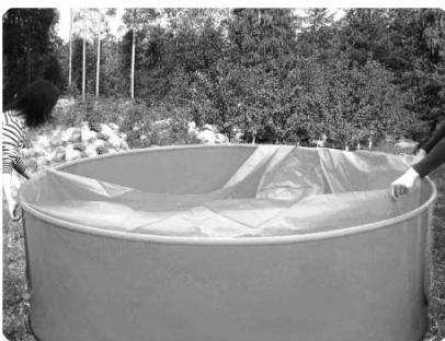
8. Начинать заполнение бассейна водой, при этом следить, чтобы пленка равномерно прижималась к стенкам каркаса.
